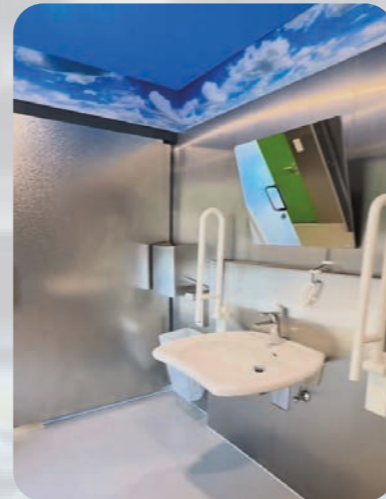
Grundschule Burgaltendorf: Überseecontainer als barrierefreie WC-Anlage
