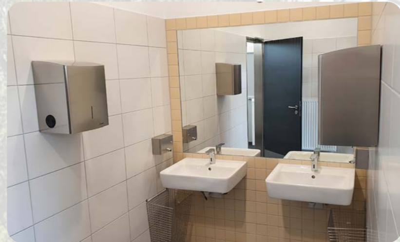
Sanierung Toilettenanlagen Gesamtschule
